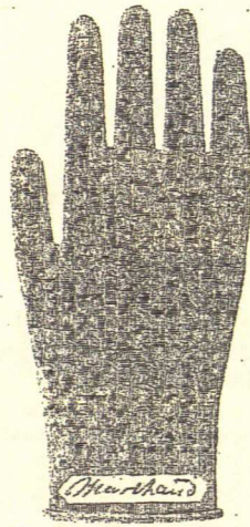
Fig. 34. Kautschukhandschuhe mit seidnem Trikotfutter und gerippter Oberfläche, nach Prof. Dr. Marchand.
